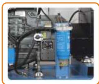
Топливный фильтр-сепаратор
